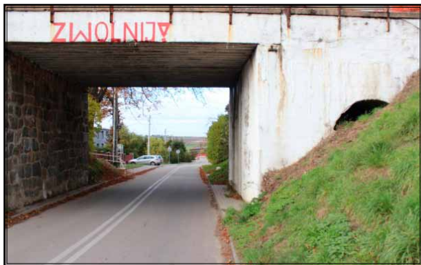
Ryc. 11. Zasypany wiadukt na ulicy Kasztanowej.
